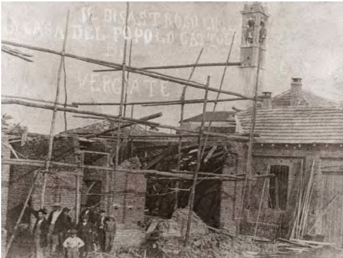
Il crollo della Casa del Popolo Cattolico, 6 ottobre 1908
