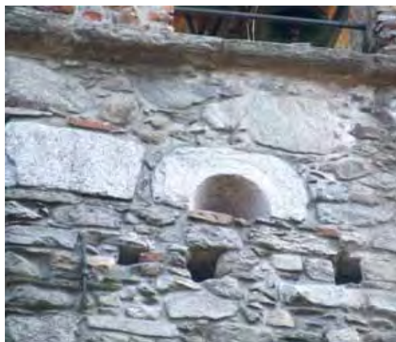
Monofora strombata e particolari decorativi romanici murati nell'attuale chiesa di S. Materno A destra, la facciata seicentesca
