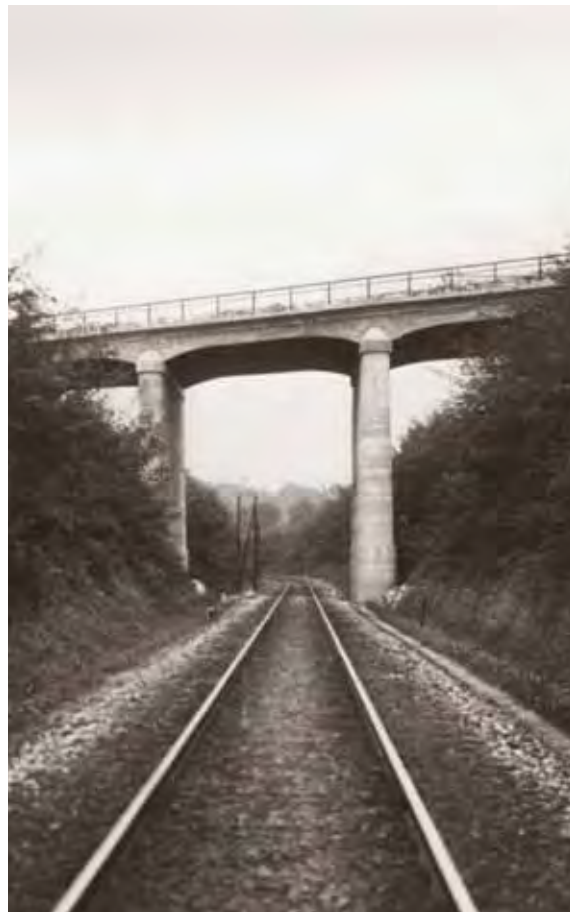
Progetto del ponte di Vergiate sulla ferrovia Gallarate-Arona e due momenti della sua ardita costruzione, 1924
