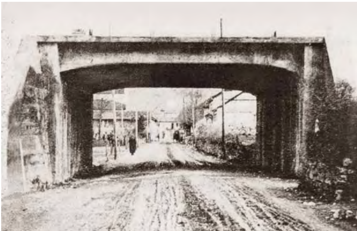
Sopra, le opere da costruirsi per l'autostrada in territorio di Vergiate nel disegno di progetto, 1923 (ACVe) Sotto, il contestato sottopassaggio della strada per la Stazione in fase di costruzione, 1923
